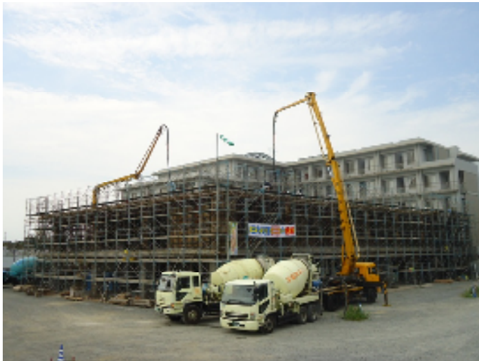
※写真：平成24年9月19日現在（コンクリート打設中）
