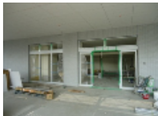
②地下1階 正面玄関
